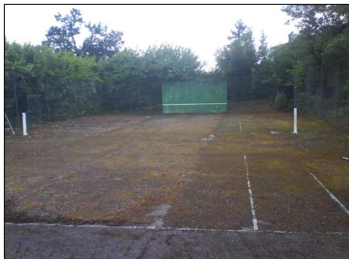
Antes de los trabajos de la reparación
